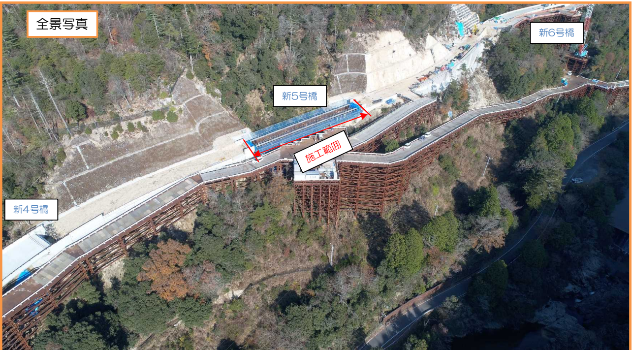
【現在の作業】 「合成床版」の架設・鉄筋組立等を行っています。
