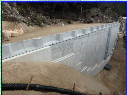
補強土壁工施工完了
