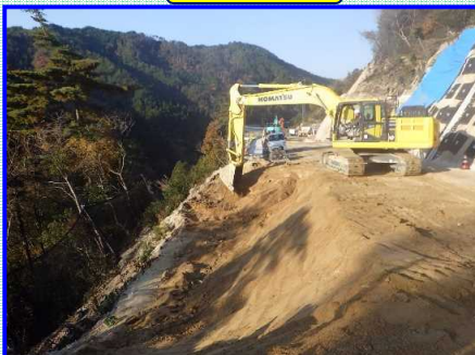
重力式擁壁掘削状況
