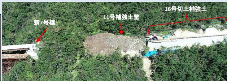
大型クレーン(220tクレーン)を使用して左下写真のように20m伐採を行いました。伐採を行った分、擁壁の施工ができますので大幅な工期短縮が可能となりました。
