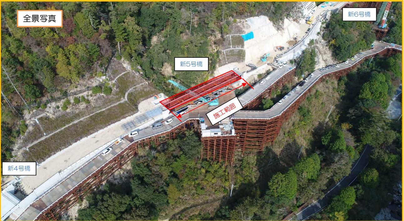
【現在の作業】 上部工の架設が完了しましたので、「吊足場」の組立てや「バント設備」の解体等を行っています。
