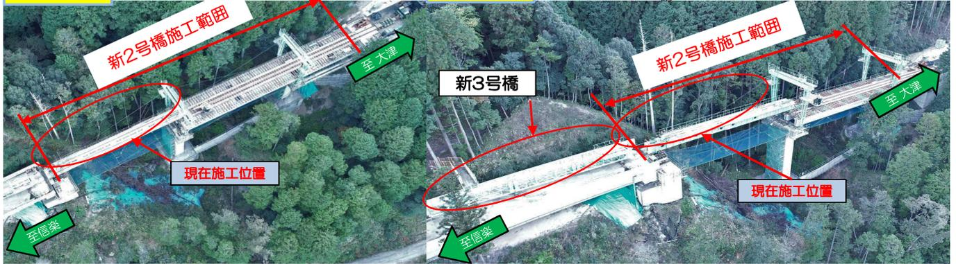
【現在の作業】 P1-P2径間架設作業終了後、最終径間(P2-A2)への架設桁移動作業を行っています。
