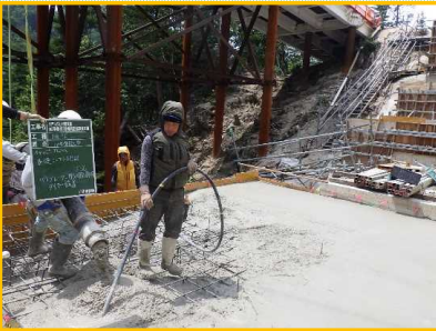
基礎コンクリート打設状況
