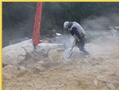
転石破碎状況
