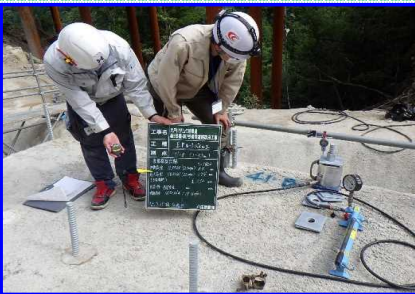
EPルートパイル試験状況
