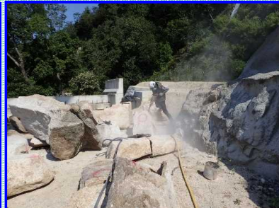
転石破碎状況
