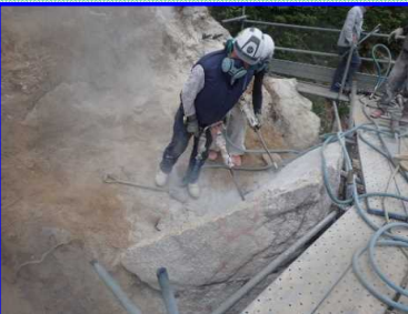
転石破碎状況
