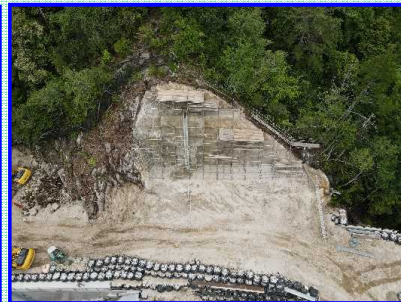
施工写真②
