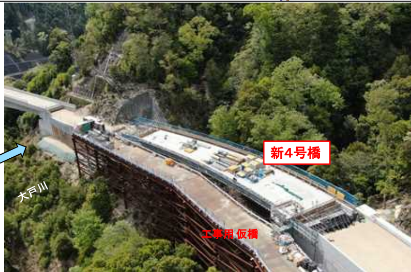
現場の進捗状況
