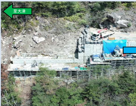
施工状況(先月)
