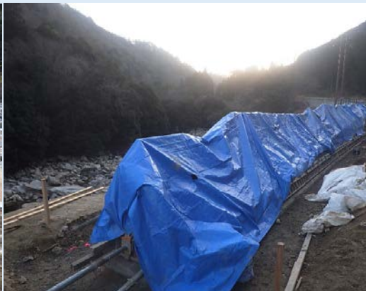
1号重力式擁壁(養生中)施工状況
