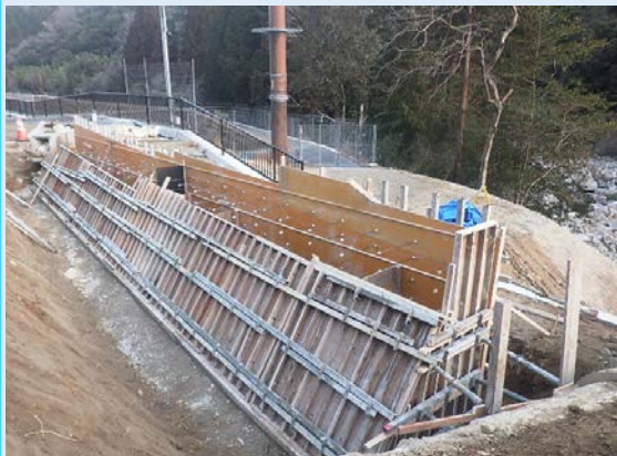
重力式擁壁施工状況
