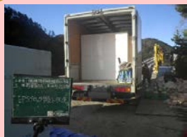
発泡スチロールブロック設置状況。
