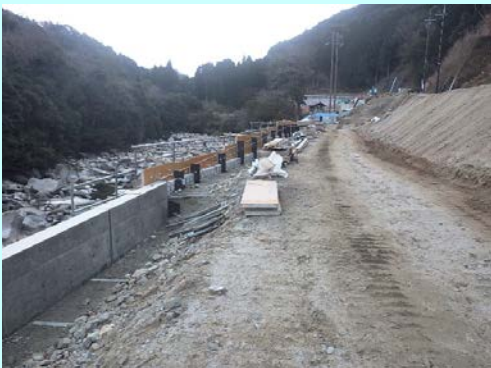
1号補強土壁 笠石コンクリート施工状況
