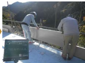
壁面のパネル設置状況。
