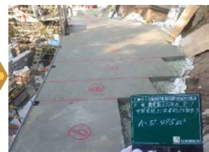
高さ3m毎に床版コンクリート打設。
