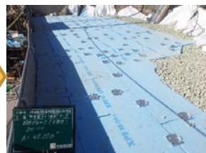
1層の発泡スチロール、パネル設置完了。
