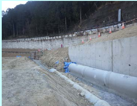
排水構造物(台付管)施工状況
