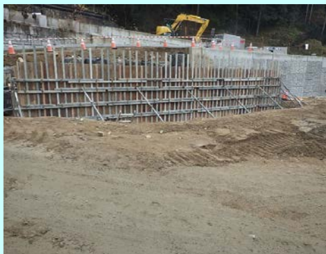
5号重力式擁壁施工状況
