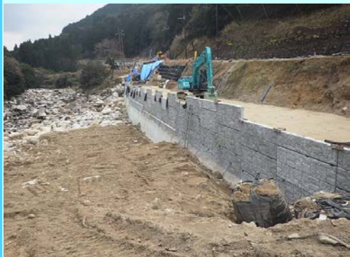
1号補強土壁 コンクリートパネル施工状況
