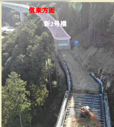
補強土壁工盛土を実施中。
