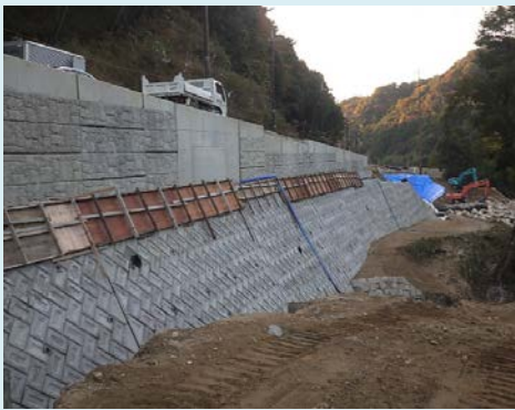
3号ブロック積天端コンクリート施工状況
