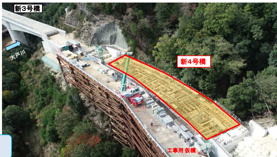
現場の進捗状況
