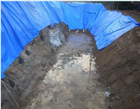
1号補強土壁掘削完了状況
