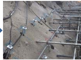
EPルートパイル設置。
