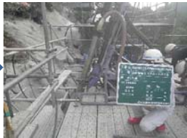
ロータリーパーカッションドリルでの削孔。
