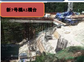
深礎工の生コン打設。
