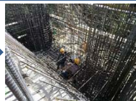
フーチング鉄筋組立
