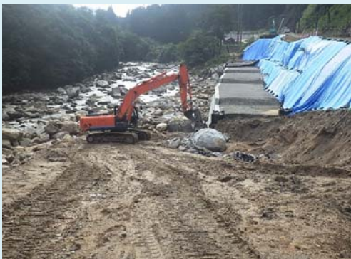
1号補強土壁掘削状況
