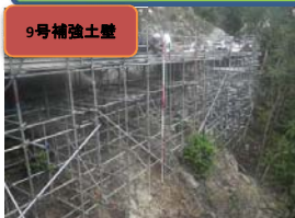
EPルートパイル足場組立。
