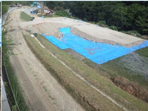
3号ブロック積施工のための仮設ヤード
