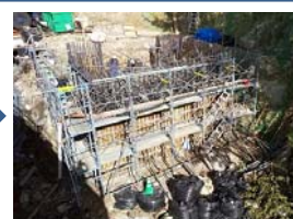
フーチング型枠組立。
