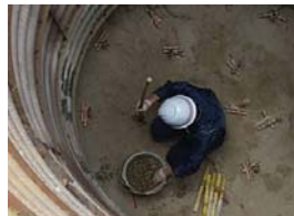
掘削が深くなったので発破の準備。
