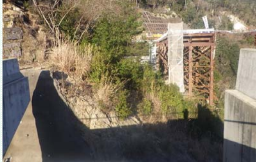
補強土壁 着工前
