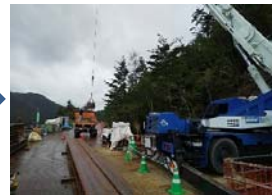
土砂バケツは25tフォークで搬出。
