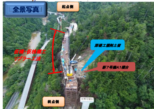
起点側からと終点側からの現場状況をドローンで撮影しました。新7号橋橋台工の深礎杭を施工中です。
