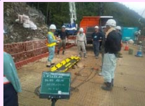
ライナープレートをセットし、ミニBH掘削。
