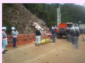
掘削が深くなったので発破の準備。
