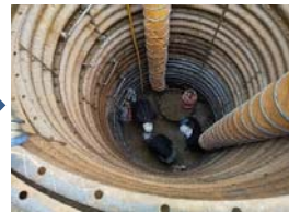
発破後土砂を人力で土砂バケツに積込
