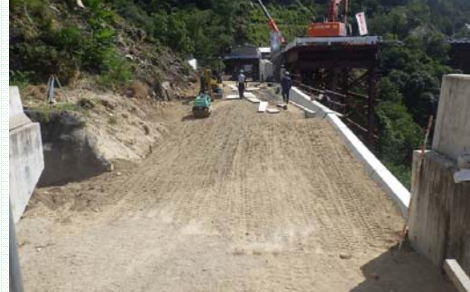
補強土壁 施工中
