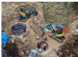
ライナープレートをセットし、ミニBH掘削。
