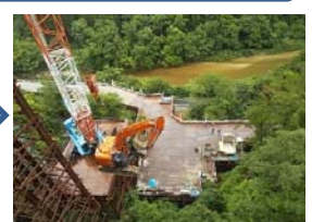
掘削完了で0.8BHを降しました。
