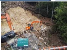
地山が岩で0.2BHのブレイカーで破碎。
