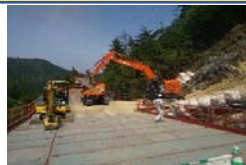
4tキリダブに積んで仮栈橋上の仮置場へ運搬。
