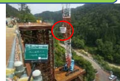
120tクレーンで下に降ろします。
