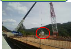
土砂バケツは25tクレーンで120tクレーンに引継。
