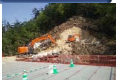
0.8m幅の道をつけ0.25m幅で掘削します。
