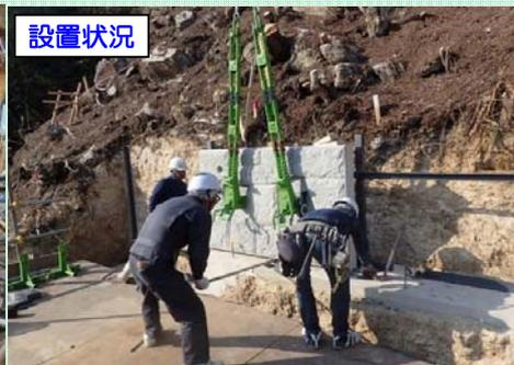
現在の作業：4月初めより事前の引抜試験後、パネル設置作業中です。
