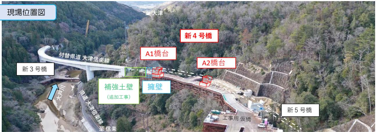
【工事の進捗】 A1橋台、擁壁が施工完了しました。A2橋台は躯体を施工中です。5月より補強土壁を施工します。
