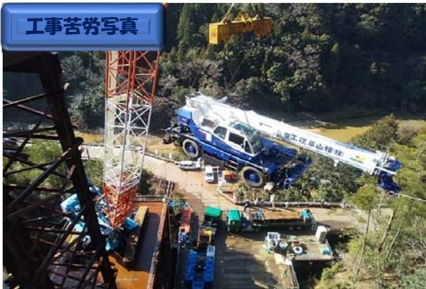
35m上の仮栈橋上で作業するために25tクレーンを吊ってる写真です。
