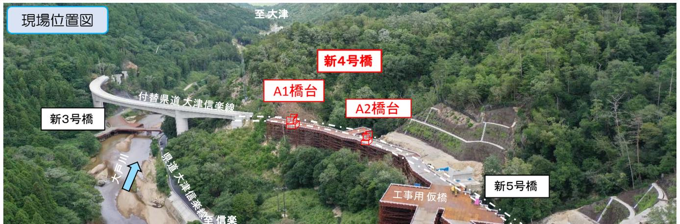
【工事の進捗】 A2橋台のH鋼親杭打設が完了しました。【今後の予定】 A1橋台の深礎工、A2橋台の床掘を行います。
