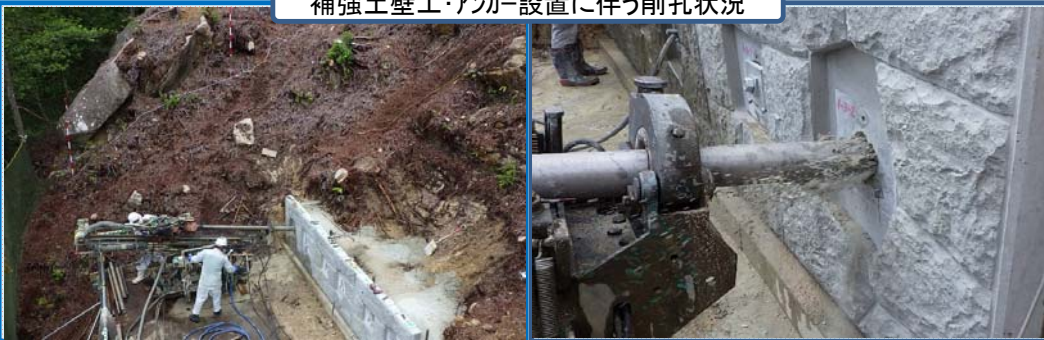
補強土壁工・アンカー設置に伴う削孔状況
