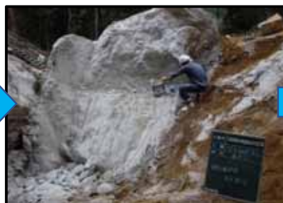
大型ブレーカー及び人力による転石の破砕状況
