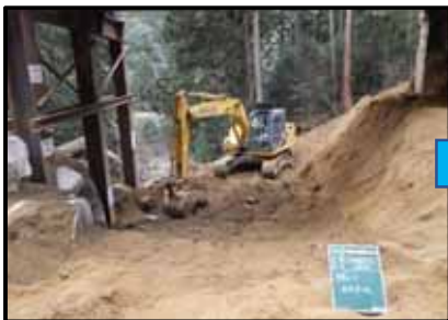
梅谷右岸側アーチカルバート基礎工の床付開始
