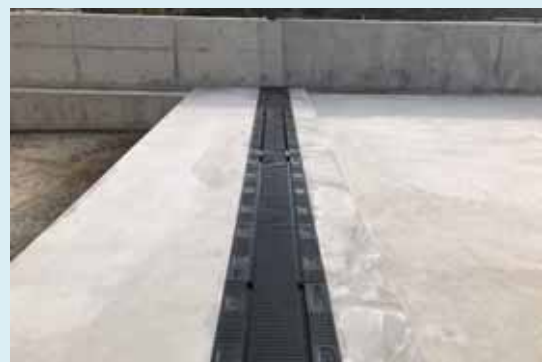
伸縮装置設置完了
