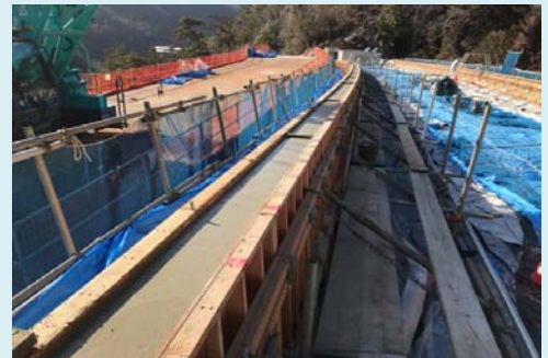
壁高欄コンクリート打ち込み完了
