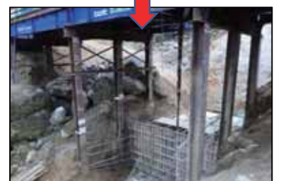
アーチカルバート基礎工スタート→
