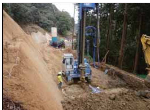
↑地盤改良工スタート
