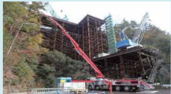
大型ポンプ車
