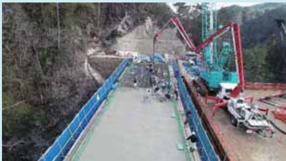
コンクリート打ち込み状況
