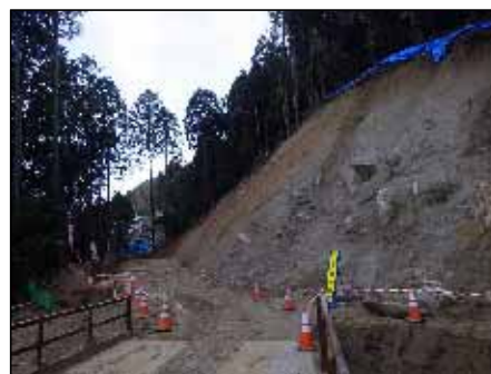
↑ 山側掘削完了
