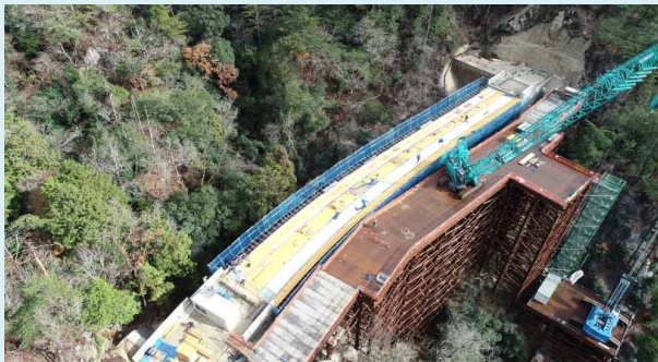
現場状況(型枠組立)の全景写真
