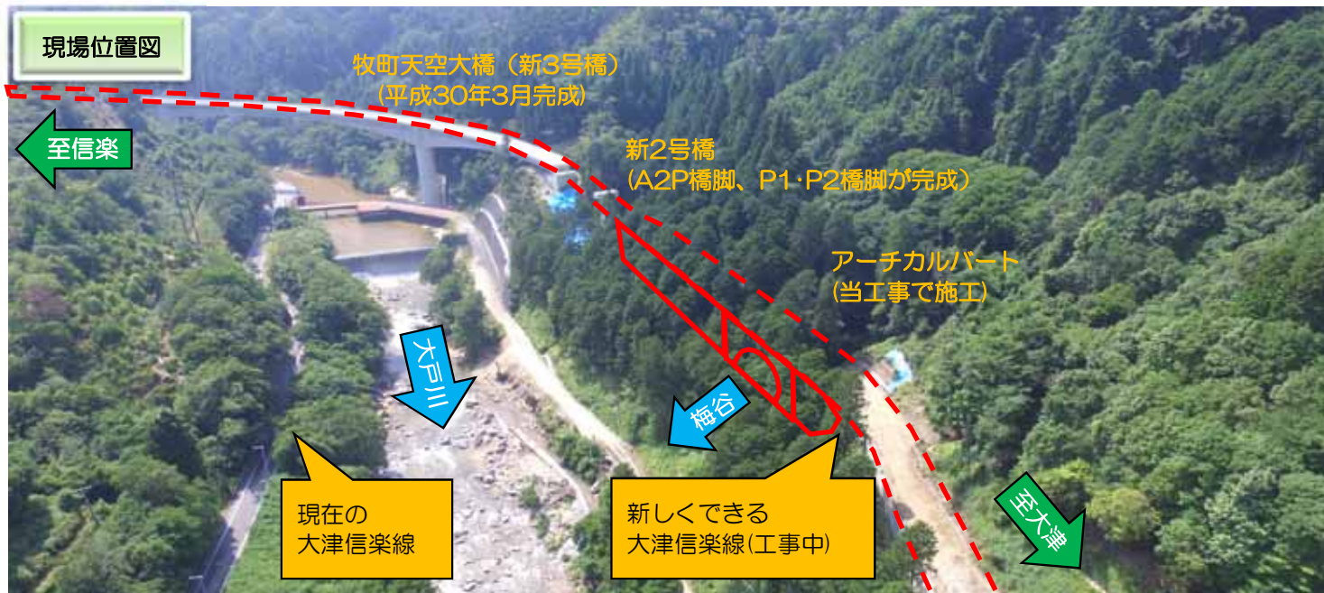
着工前(H30年5月撮影)
