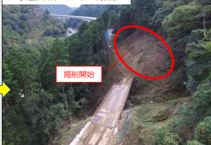
工事進捗状況(H30年10月撮影)
