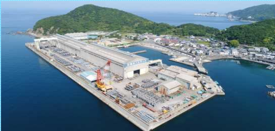
【駒井ハルテック 和歌山工場】
