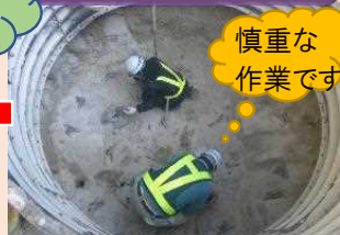
火薬装薬作業中
