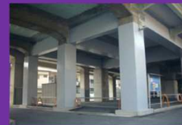
鋼板巻立工法
