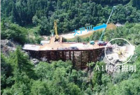
掘削・転石破碎(作業場が転石で満杯です)
