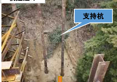
光波測距儀での杭芯のズレ測定
