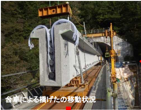
トンネル内での特殊機械による橋げたブロックの荷卸し状況
