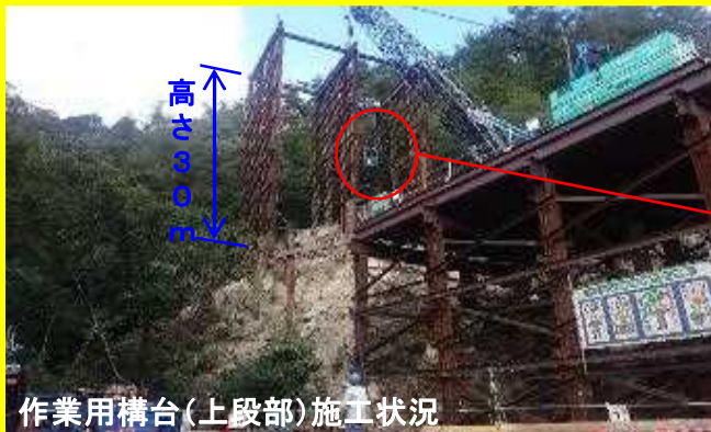
スパイダー工法(電動ゴンドラ設備)
