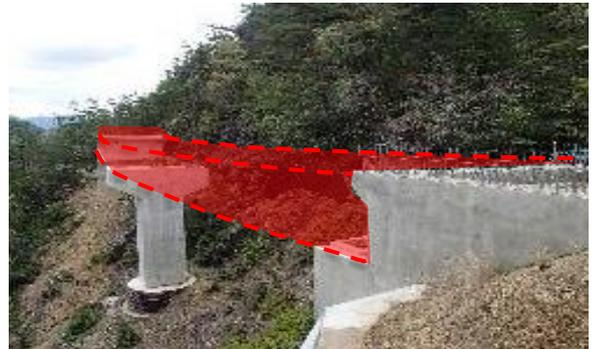
今回施工する橋梁は、橋桁を工場で8m~10mの長さ分割製作し、これを施工位置まで運び、連結組立を行い架けるPC桁橋と言います。現在は桁の型枠を工場にて製作中です。その後、鉄筋・型枠組立、コンクリートを流し込み桁完成となります。現地作業は転落・落下物防止のためワイヤーブリッジ（足場）の設置作業を9月20日から行います。
