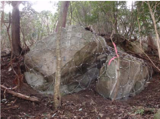
ワイヤネット被覆工 施工完了
