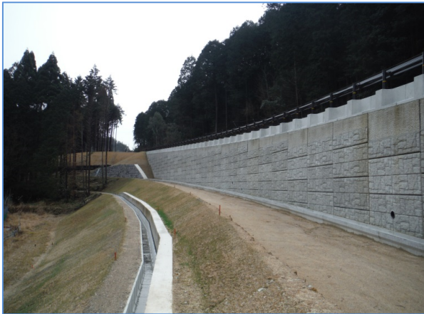
工事用進入路2 (NO.2)
