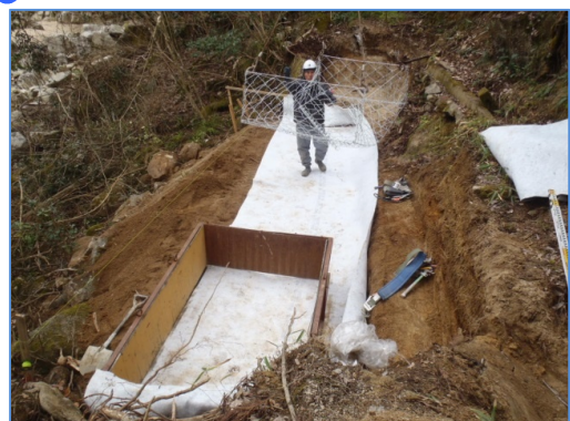
工事用進入路況写真(2月15日) (No.25付近) 護岸補修(フソカゴ)を施工しています。
