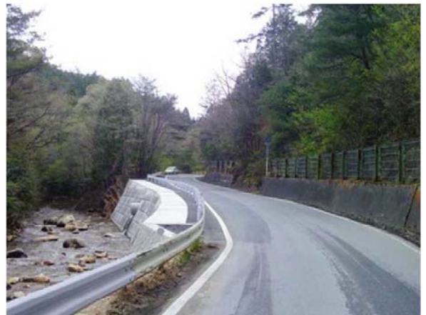
(上の写真) 護岸工(大型ブロック積擁壁)が完成しました。
