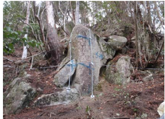
ロープ掛工 施工完了
