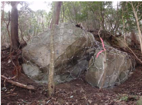
ワイヤネット被覆工 施工完了
