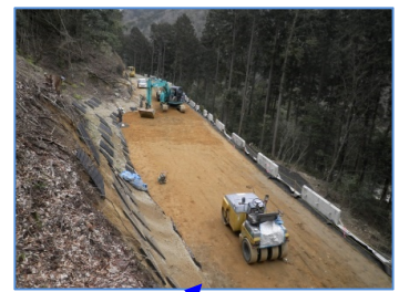
5号補強土壁部(道路の上面整正)
