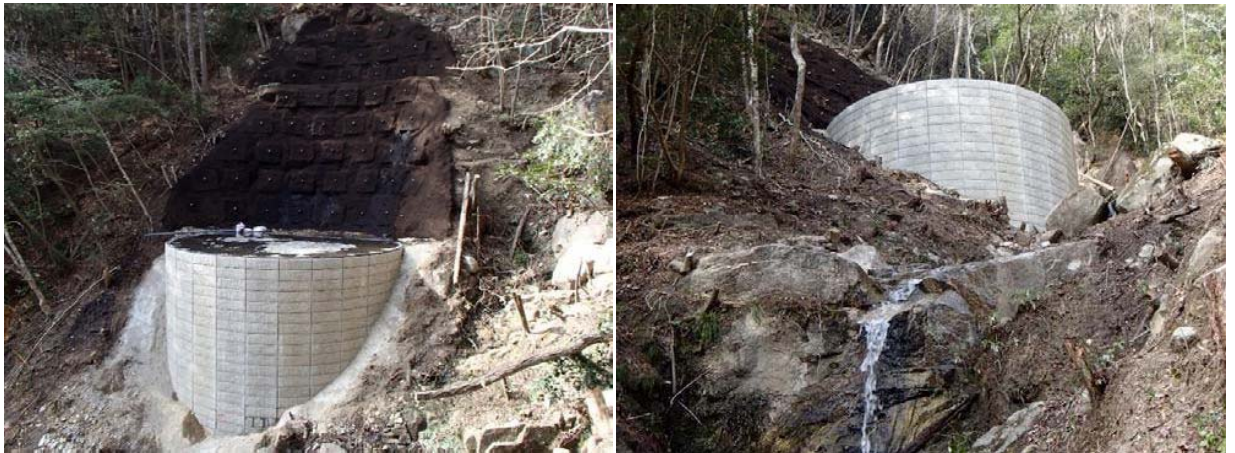
【新7号橋】 基礎施工作業台が完成しました。
