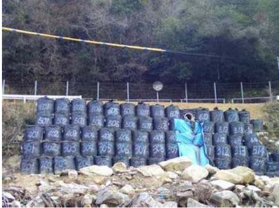
(上の写真) 施工前
