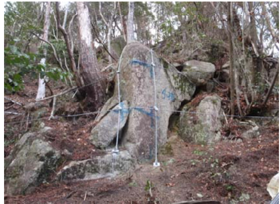
ロープ掛工 施工完了
