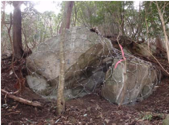
ワイヤネット被覆工 施工完了
