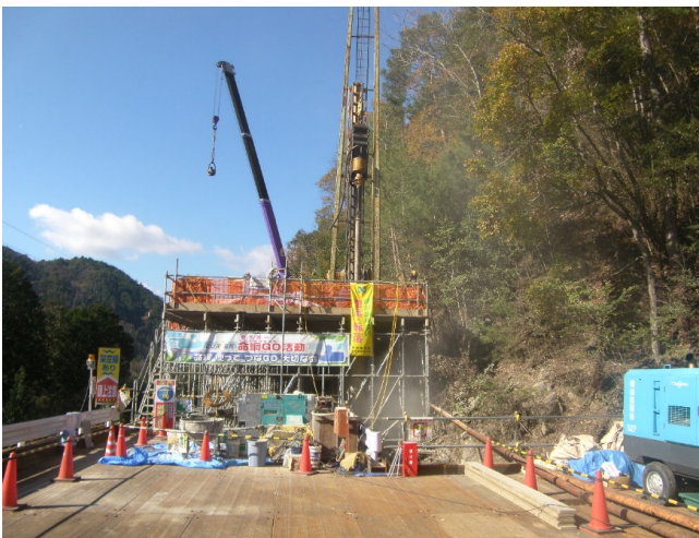
(支持杭施工状況)
