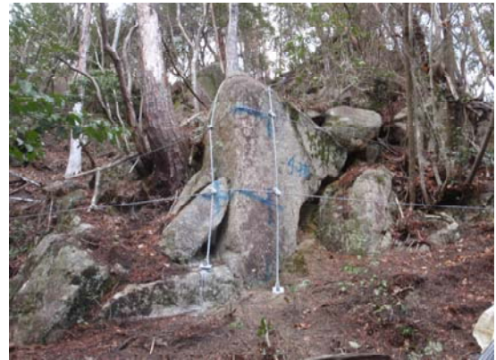
ロープ掛工 施工完了
