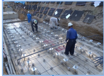
5号補強土壁部状況写真
