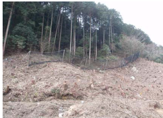
落石防護柵工 施工完了
