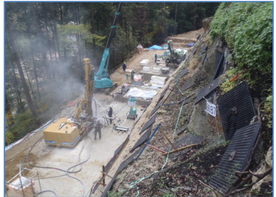
付替県道現況写真(11月14日) (No.121付近) 5号補強土壁の基礎工を施工しています。
