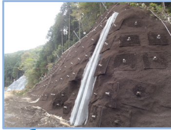
2号切土補強部状況写真
