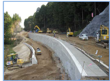
3号補強土壁部状況写真
