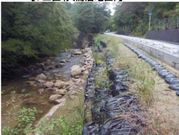
(上の写真) 施工前
