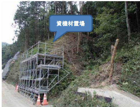
【A2P橋脚】(大戸川左岸部)
