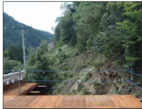
伐採が完了しました。
