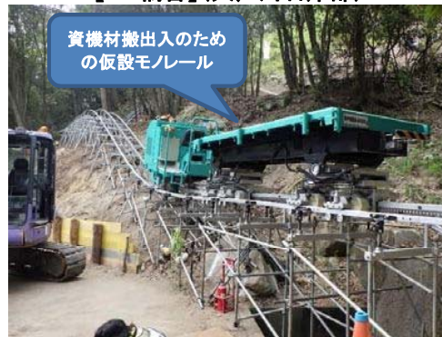
【A2橋台】(大戸川右岸部)
