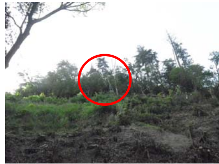
【A2橋台】(大戸川右岸部)
