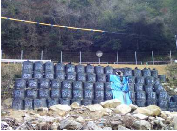
(上の写真) 施工前
