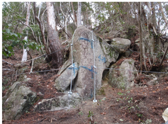
ロープ掛工 施工完了
