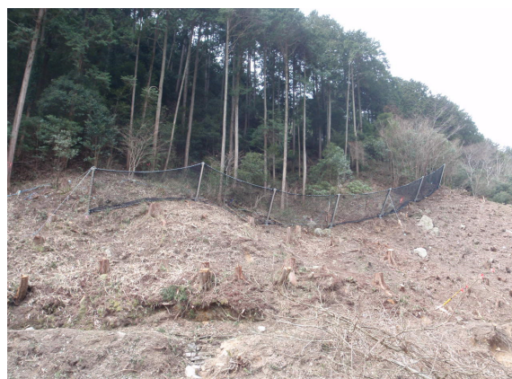
落石防護柵工 施工完了
