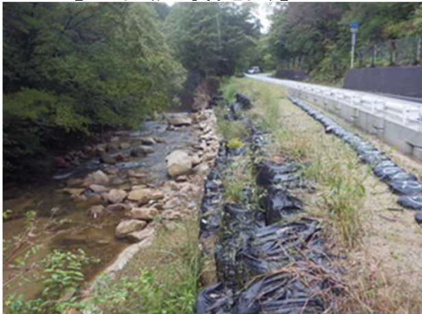
(上の写真) 施工前
