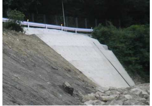
(上の写真) 護岸工(コンクリート擁壁)が完成しました。
