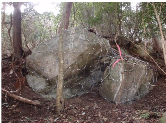
ワイヤネット被覆工 施工完了
