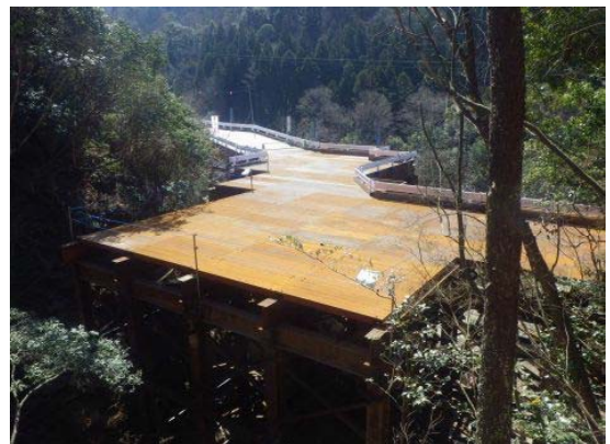
完成写真② 作業構台部
