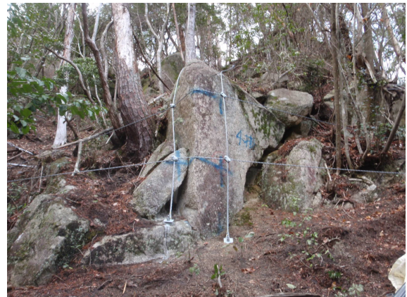
ロープ掛工 施工完了
