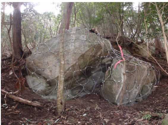
ワイヤネット被覆工 施工完了
