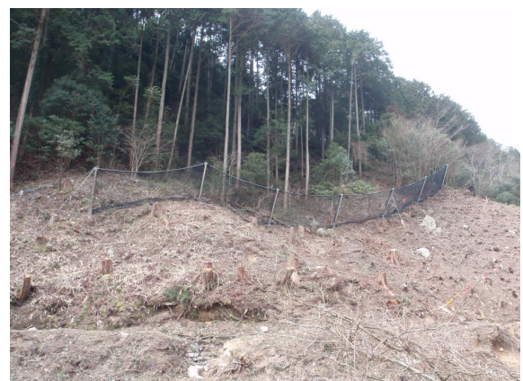
落石防護柵工 施工完了
