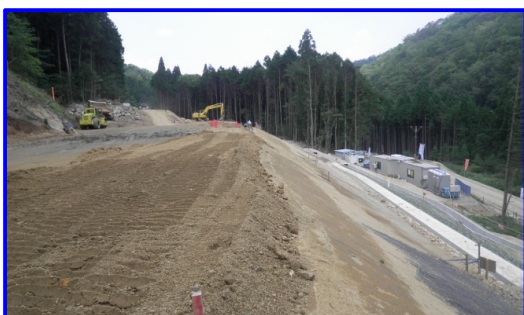
高盛土部 全体写真 (Overall Photo of High Embankment Section)
