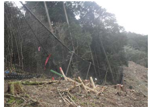
落石防護柵設置完了
