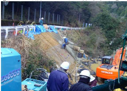
法面にモルタルを吹付ています。 (上の写真)
