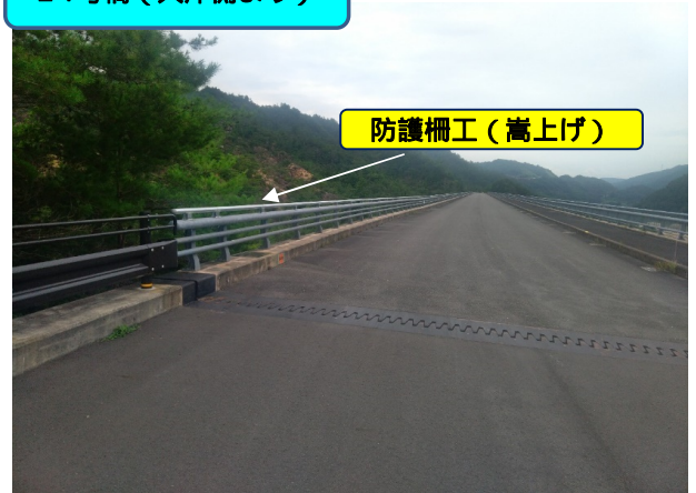
24号橋 (大津側より)
