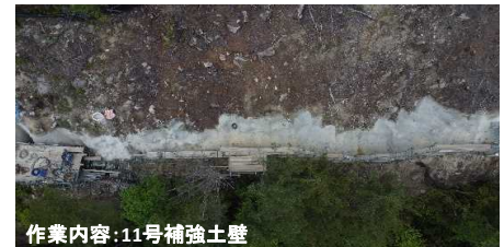
作業内容: 11号補強土壁
