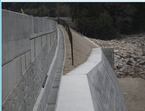
転落防止柵設置状況
