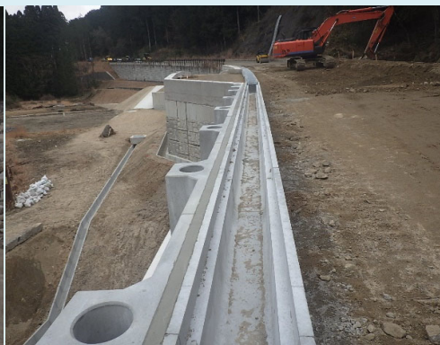
排水構造物 側溝設置完了
