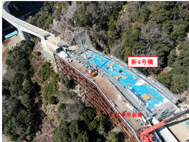
現場の進捗状況
