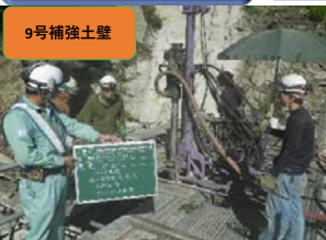
ローリーバー・カッショントリルでの削孔。
