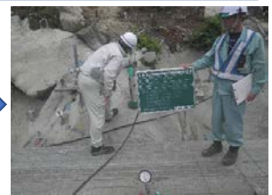
EPルートパイルの性能を確認。
