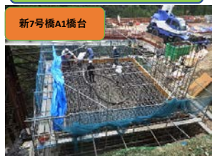
フーチングコンクリートの打設。
