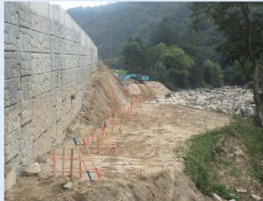
3号ブロック積施工のための丁張状況
