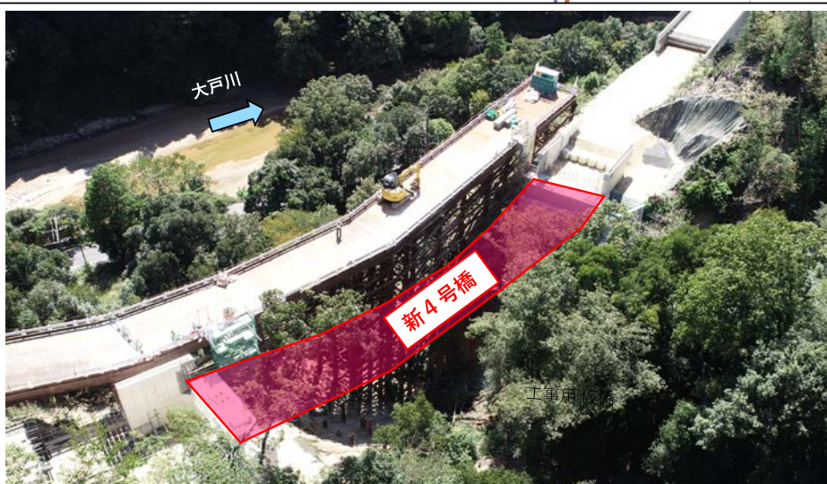
現場の進捗状況
