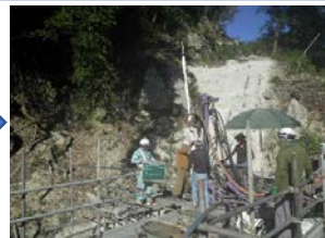
EPルートパイル芯棒挿入。
