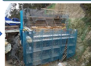
胸壁・翼壁施工中。
