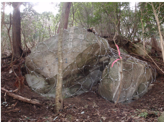
ワイヤネット被覆工 施工完了
