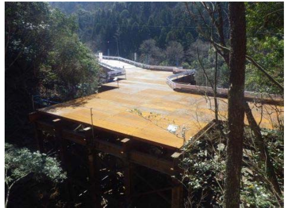
完成写真② 作業構台部
