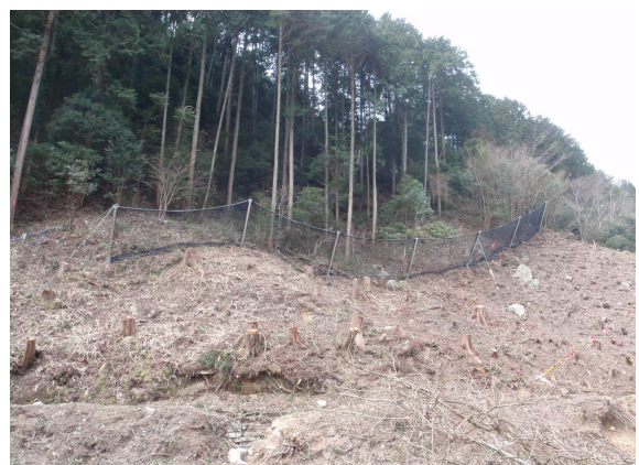
落石防護柵工 施工完了
