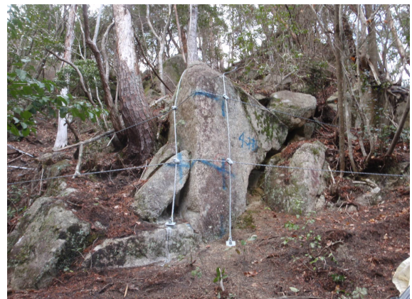
ロープ掛工 施工完了
