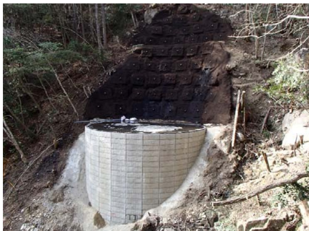
【新7号橋】 基礎施工作業台が完成しました。
