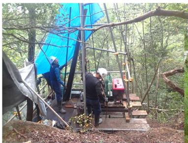
ボーリング調査
