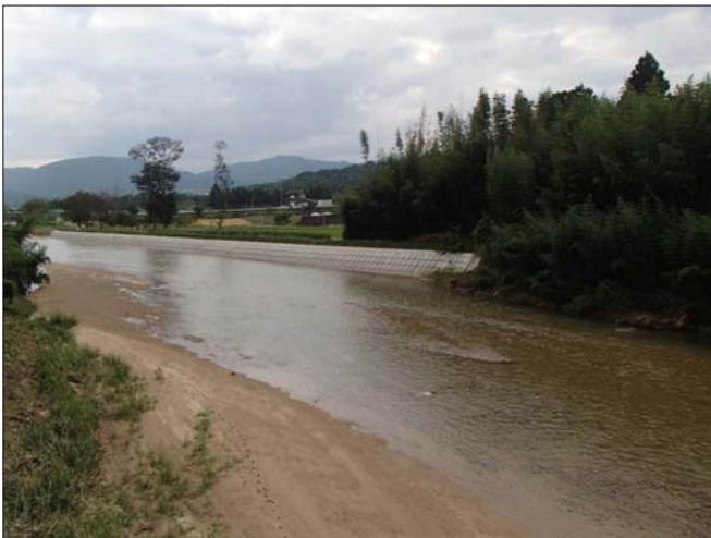
⑨堂村橋下流右岸(災害復旧箇所)
