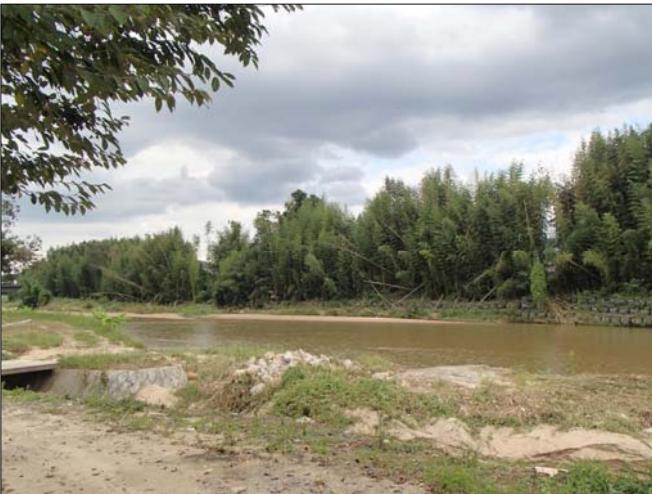
⑫羽栗橋上流右岸(浸水箇所)
