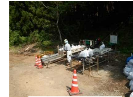
モノレール(立坑閉塞)
